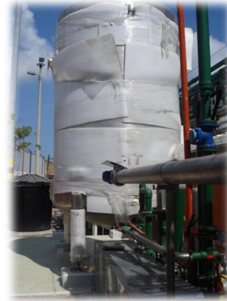
Instalación de tanques
